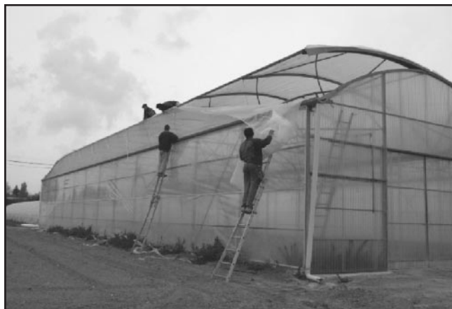
Pose d'un filet insect-proof sur une serre multichapelle
